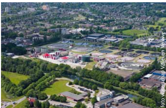
Project RWZI Apeldoorn (waterschap Vallei en Veluwe): installatie in aanbouw (op terrein links op de foto) voor terugwinnen fosfaat en energie
