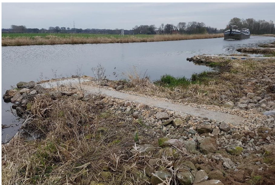
Figuur 3.6 Langs de Oude IJssel zijn speciale 'viskribben' aangelegd (foto: Frank Bosman).
